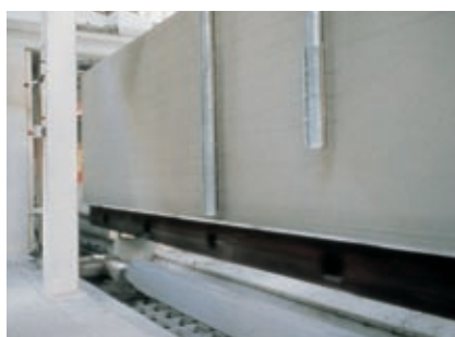
Produzione AIRBETON®: taglio dei blocchi tramite fili di acciaio.
