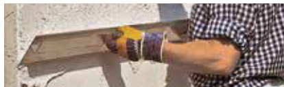
Intonaco leggero monostrato su muratura esterna AIRBETON. Lisciatura con tavola di legno.
