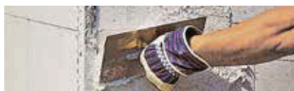
Intonaco leggero monostrato su muratura AIRBETON. Applicazione del primo strato.
